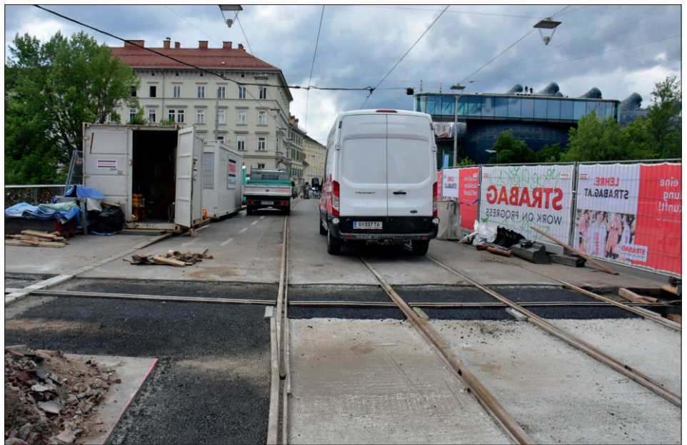
Die bereits eingebauten Dilatationen auf der Erzherzog-Johann-Brücke.
