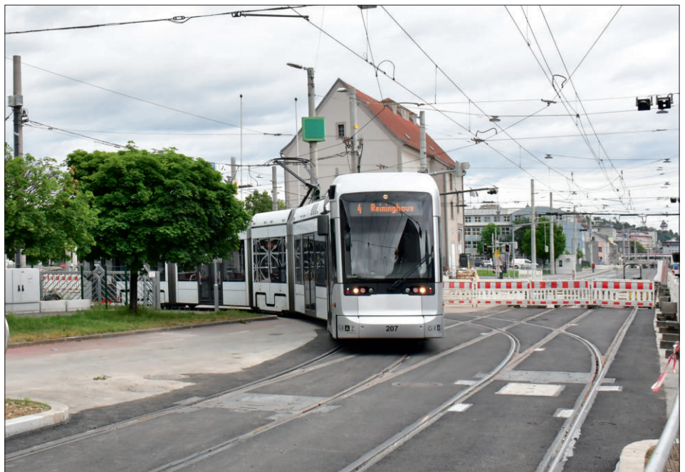
Die bereits eingebauten Dilatationen auf der Erzherzog-Johann-Brücke.
